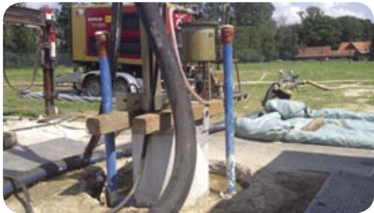
Pumpentest im neuen Brunnen
