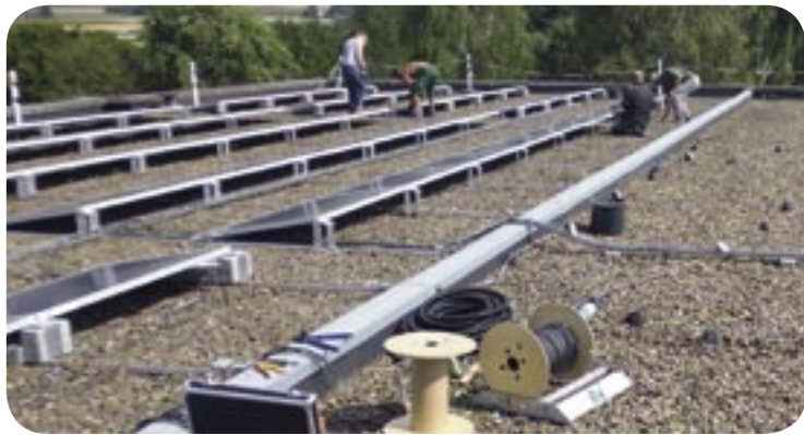
Montagearbeiten auf dem Dach - alles wurde rechtzeitig fertig!
