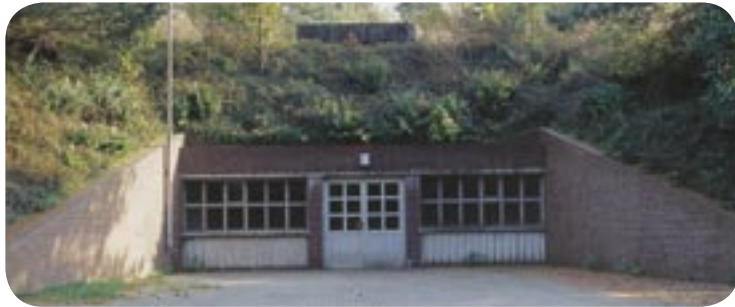
Der Hochbehälter Recke: Eingang.
