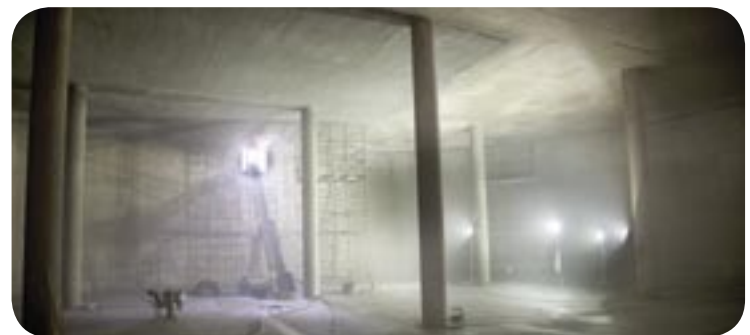
von innen: Die Wasserkammer des Hochbehälters - ohne Wasser
