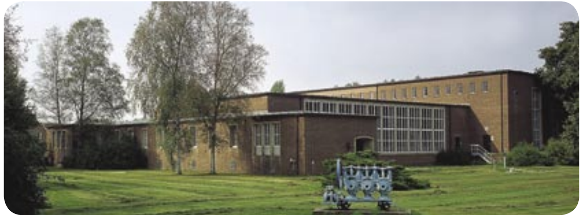
Wasserwerk (WW) Dörenthe - Gebäudeansicht
