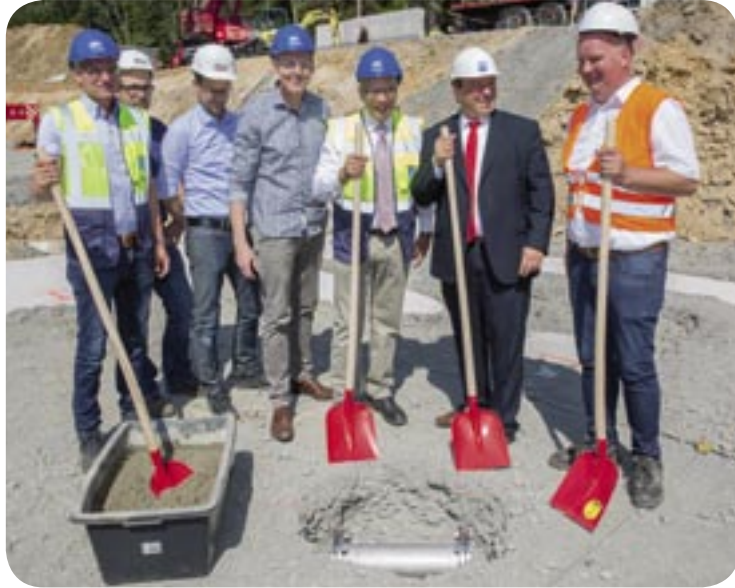
Schweißtreibend: der Grundstein ist eingesetzt
